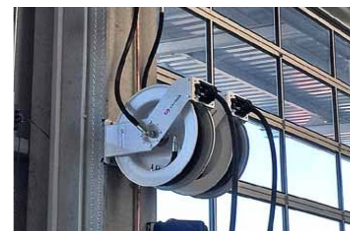
Samoa-Hallbauer-Schlauchaufroller mit reibungsarmen Drehlagern und Drehgelenk mit hohem Durchfluss
